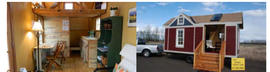
오레곤주 알바니의 Tiny SMART House 개방형으로 바람이 잘 통함. 대학생을 염두에 두었으나 게스트하우스나 별장 용도로 사용하겠다는 요청을 받음.
